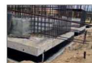
Гидроизоляция фундаментов
