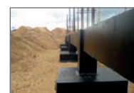
Гидроизоляция сваи
