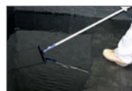
Нанести 1-й слой на огрунтованную поверхность
