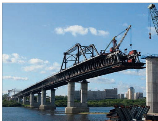
Гидроизоляция мостовых сооружений. Метромост, Н. Новгород
