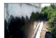
Гидроизоляция методом напыления
