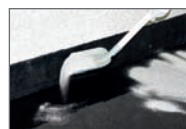
Получившийся монолит необходимо защитить
