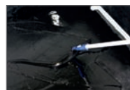
Наносить тремя слоями (слой 3-4 мм)
